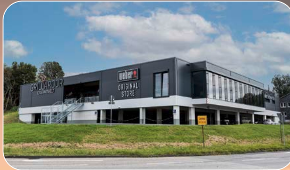
Hochbau Weber Original Store Grillardor
