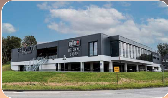
Hochbau Weber Original Store Grillardor
