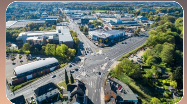
Umbau Straßenkreuzung Trecknase B 229 / B 51
